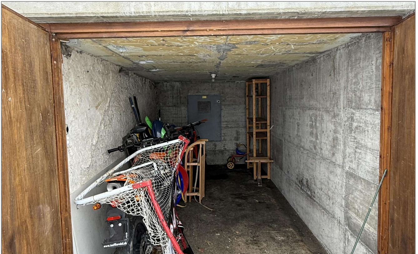
Abstellraum mit Zugang zum Oeltank
