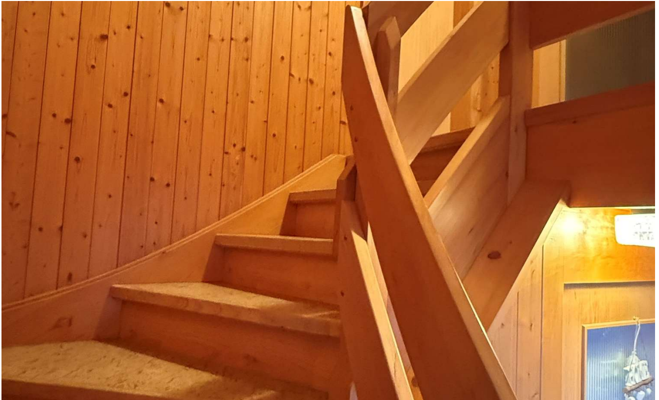
Treppe zu OG
